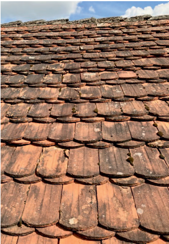
mit Biberschwanzziegeln gedecktes Dach
