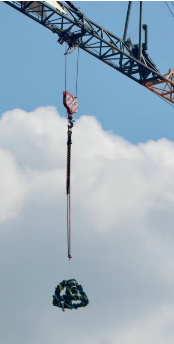
Die Richtkrone am Kranhaken
